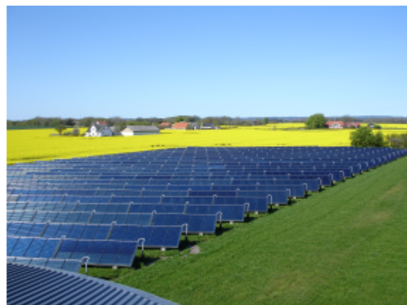
Fig. 4. Eksempel på solvarmeanlæg.
