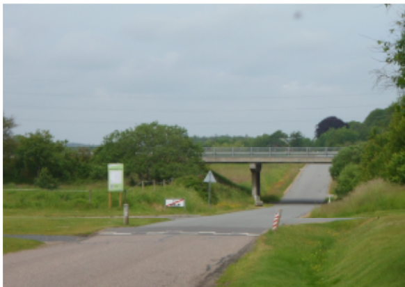
Fig. 3 Lokalplanområdet (bag viadukten) set fra øst langs Askærgårdvej.
